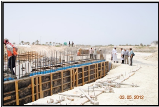
شكل (5): بناء غرفة ترشيح مياه الأمطار في موقع آبار التغذية بحوض الزلاق
