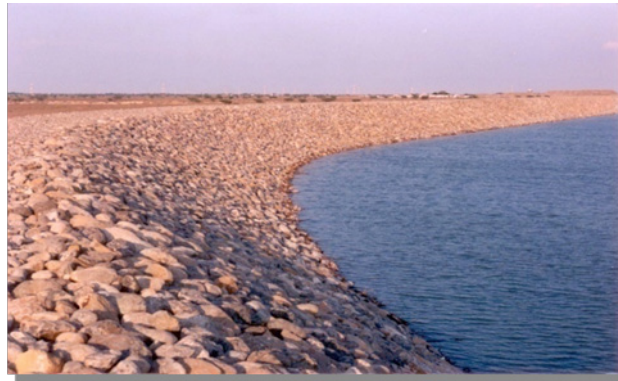
الصورة توضح عمليات الإنشاء لسد التغذية الجوفية على وادي الصاروج
